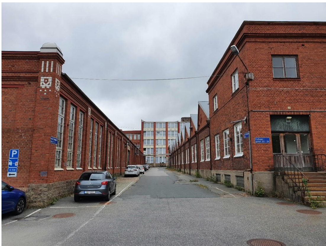
Figur 9. Befintliga byggnader (till höger M-fabriken och vänster R-fabriken) som planeras att bevaras (foto Tyréns 2021-07-09).
